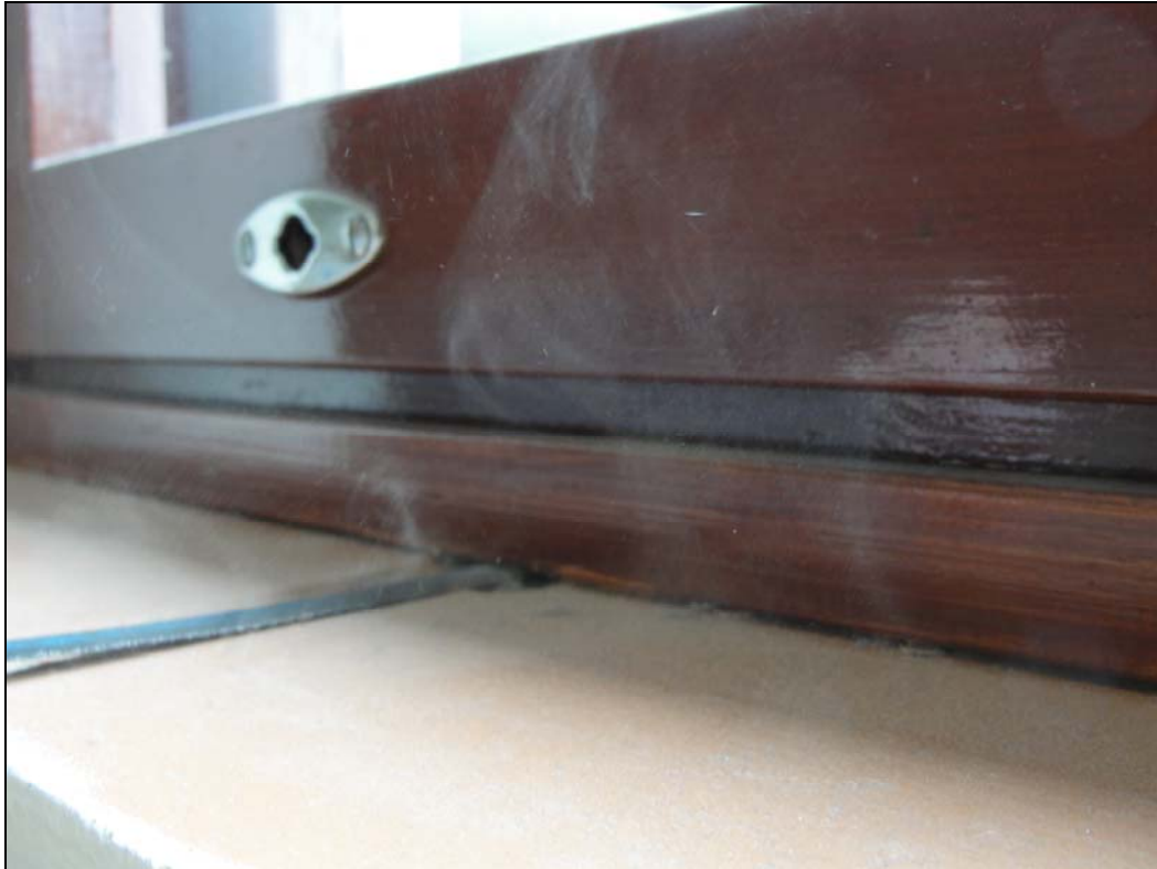
Kuva 4. Ikkunoiden tilkevälin pöly osoittaa, että ilmavirtaus rakenteesta on sisätiloihin.
